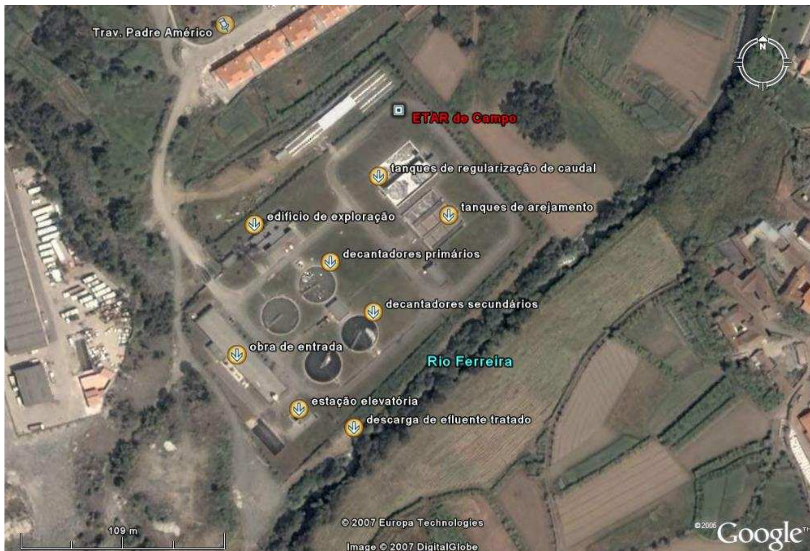
Figura 3 – Vista aérea da ETAR de Campo. Localização dos principais órgãos de tratamento e edifícios de apoio. (Google Earth, Janeiro 2007).
